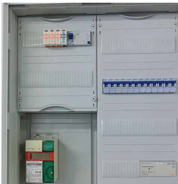
Imagem 1: Descarregador combinado ipo 1+2, V50 3+NPE-280, no quadro principal
