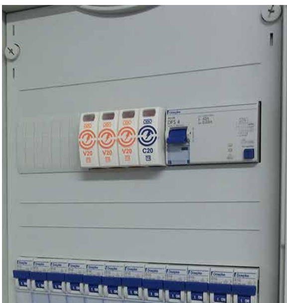
Imagem 2: Descarregador de sobretensões tipo 2, V20 3+NPE-280, no armário de controle
