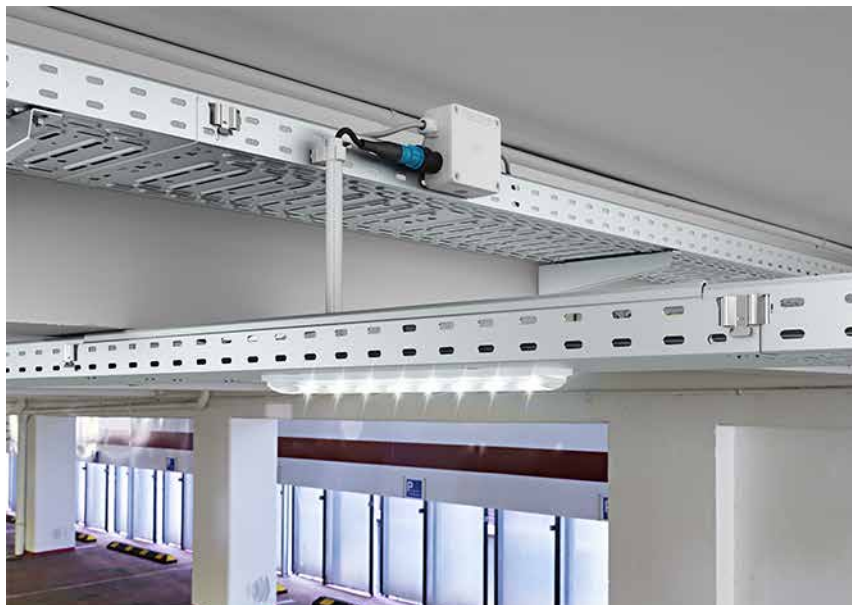
Imagem 3: Descarregador de sobretensões tipo 2+3, ÜSM-LED 230, na caixa de derivação montada no sistema de caminho de cabos
